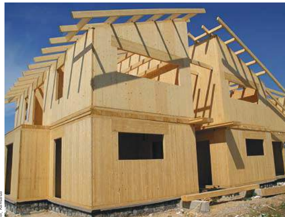
Dom z drewna klejonego w systemie HBE.
